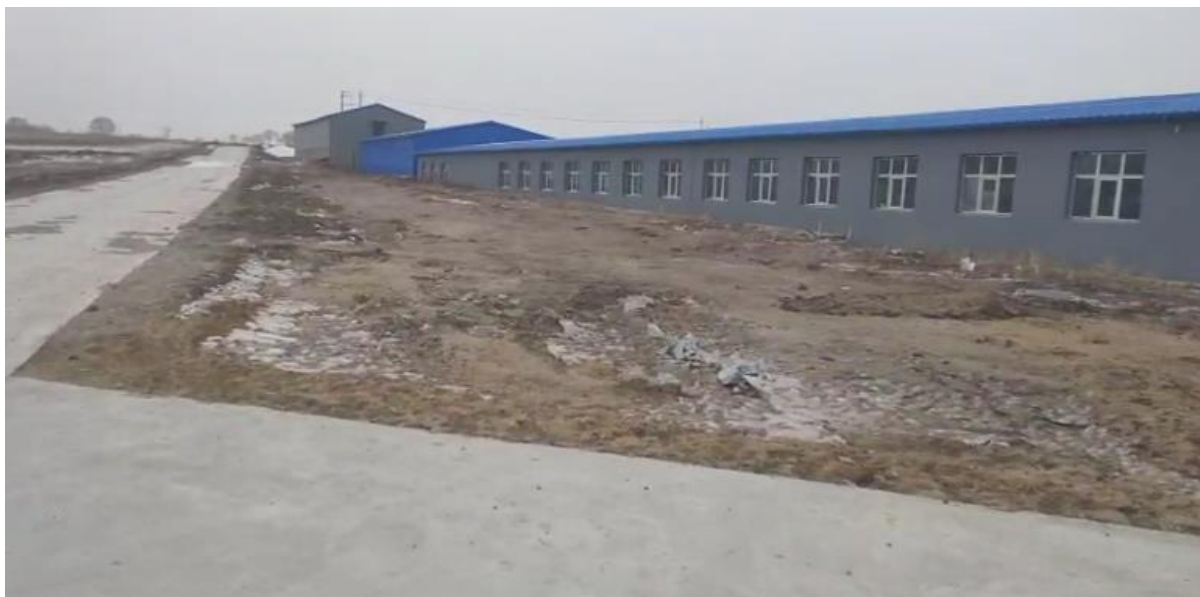
图 1-4 项目道路硬化现状
