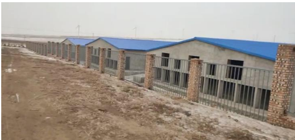
图 1-3 项目建构筑物基础及现状
