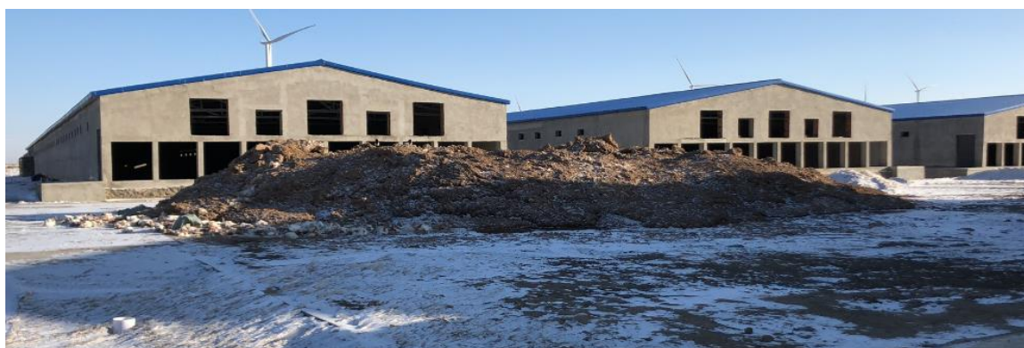
图 1-6 项目临时堆土区现状
