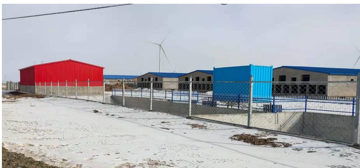
图 1-3 项目建构筑物基础及现状
