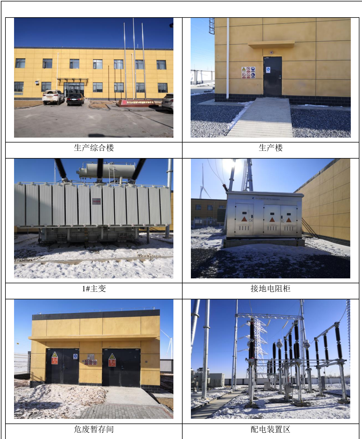
图 4-1 补龙湾 220kV 升压站工程概况
