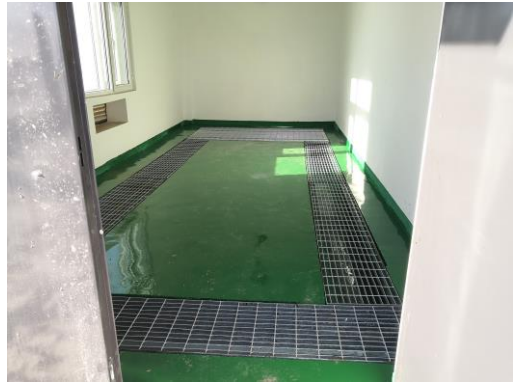
危险废物暂存间内部
