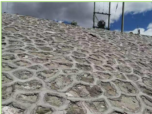
升压站周边浆砌石护坡监测
