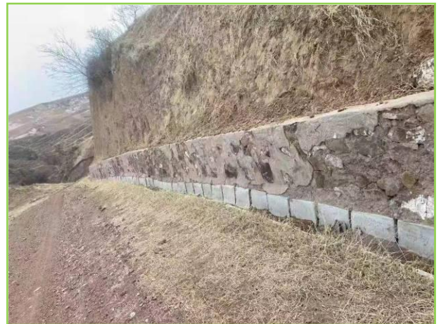
施工道路浆砌石护坡及预制排水沟监测
