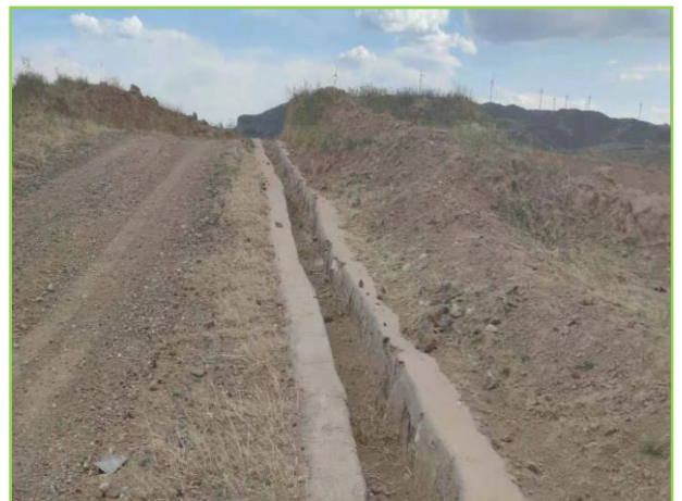
施工道路植被恢及浆砌石排水沟
