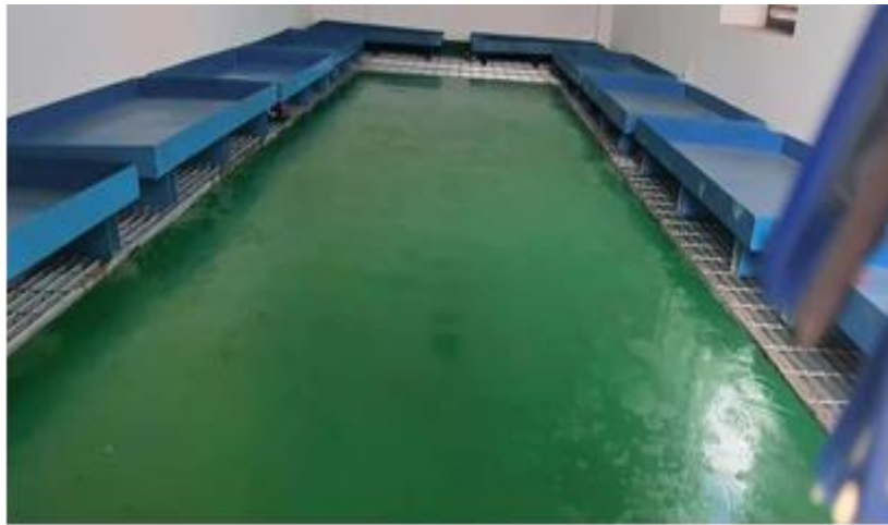
危险废物暂存间内部
