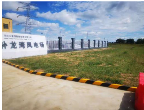
升压站扰动范围内生态恢复
