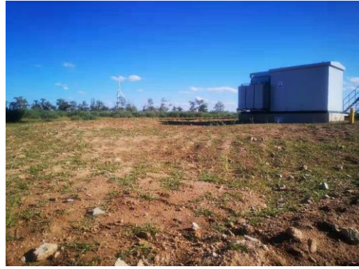
箱变区生态恢复
