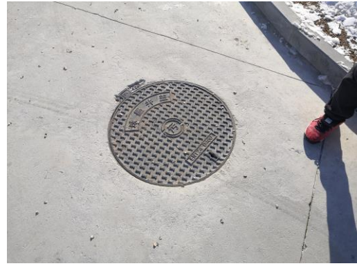
升压站内隔油井
