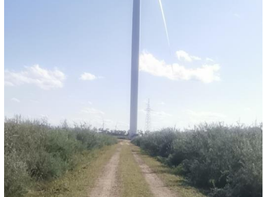
风场检修道路生态恢复
