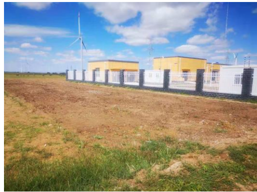
施工生产生活区生态恢复
