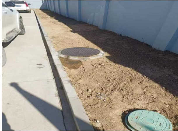
图 4.1-1 化粪池现状照片
