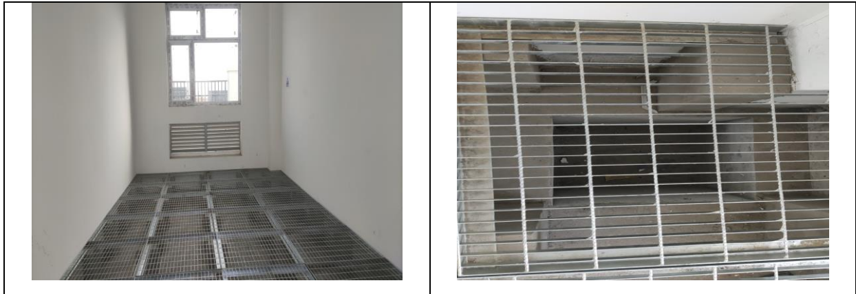
图4.1-3 危废暂存间标识及收集池等现状照片
